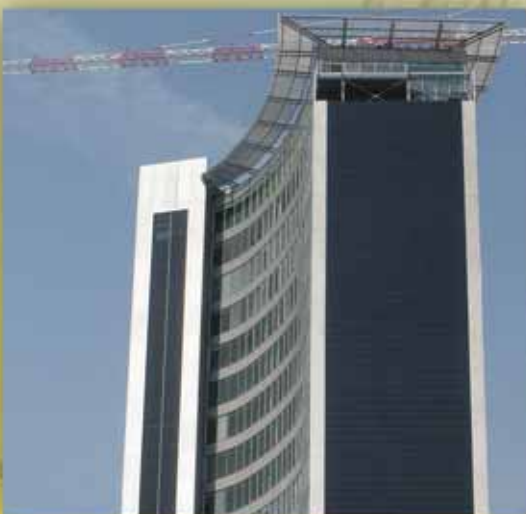
MILANO - WJC impianto fotovoltaico integrato in facciata ventilata
