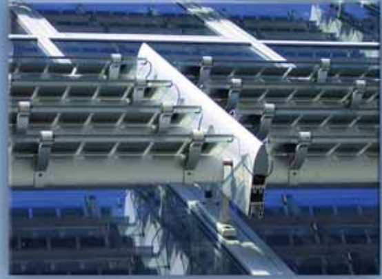
FAENZA - Gimo immobiliare - Frangisole fotovoltaico
