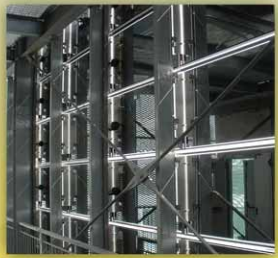
MILANO - WJC impianto fotovoltaico integrato in facciata ventilata
